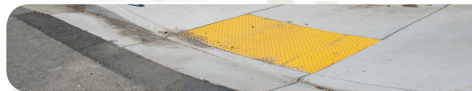
ADA Compliant Ramps
